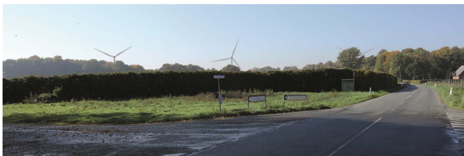
Figur 20 - Fotopunkt 2: Visualisering af vindmølleområdet fra krydset mellem Stenmurevej, Boelsmosevej og Hesselagergårdsvej - 1.127 meter til nærmeste vindmølle.
